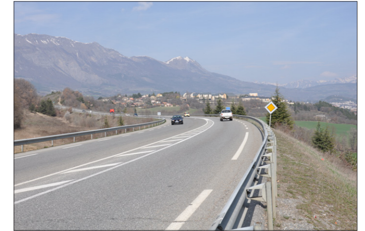
La RN 85 aux abords de Gap par le Sud
